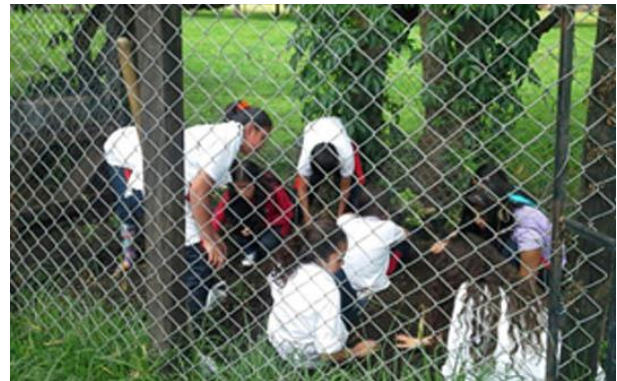
Imagen 7: Adecuación de terreno.
