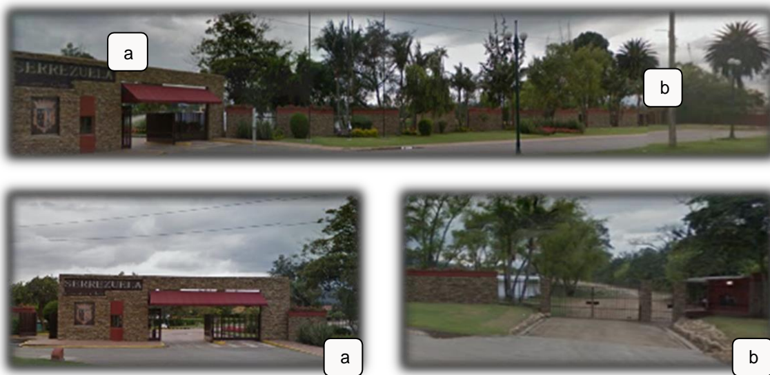
Imagen 19. Fachada y puntos de acceso para socios-invitados (a) y trabajadores-proveedores (b)
