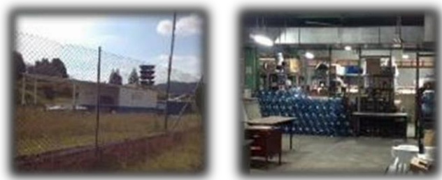
Imagen 44. Planta de tratamiento y almacén
