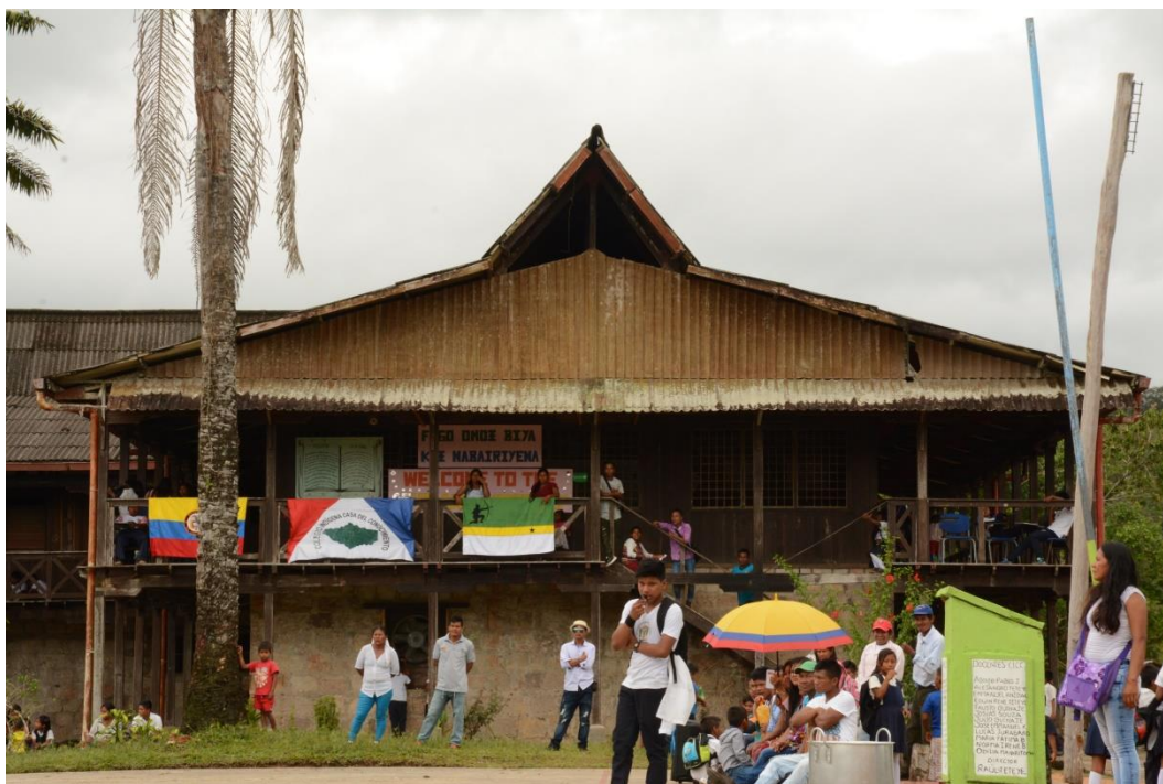
Foto:Daniela Peña. Fachada de colegio Casa del Conocimiento
