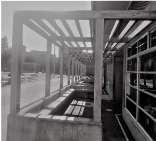
(1) Espacio seleccionado para la instalación
