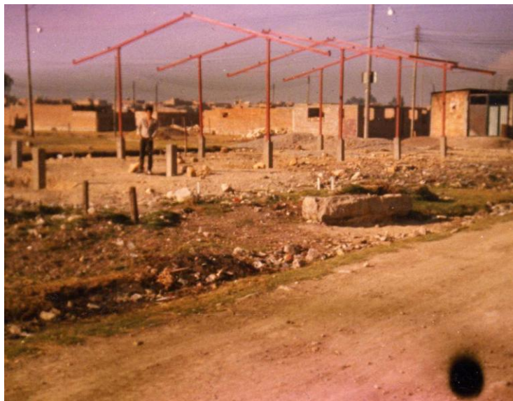
(Construcción de la iglesia del barrio Tintalito)
