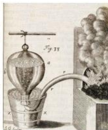
Ilustración 3. Cuba Hidroneumática diseñada por Hales.
