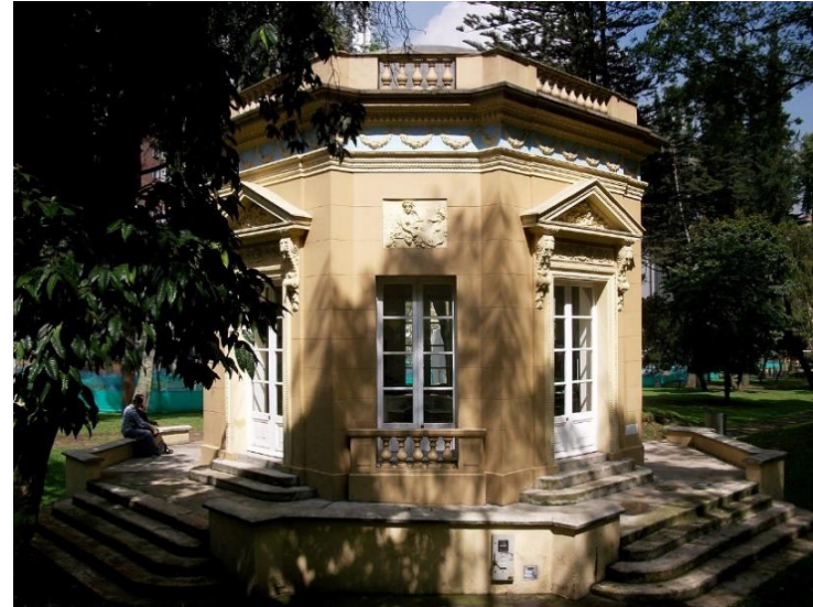
Figura 9. quiosco de la luz ubicado en el parque de la independencia Bogotá Colombia, donación realizada por cementos Samper en 1910.
