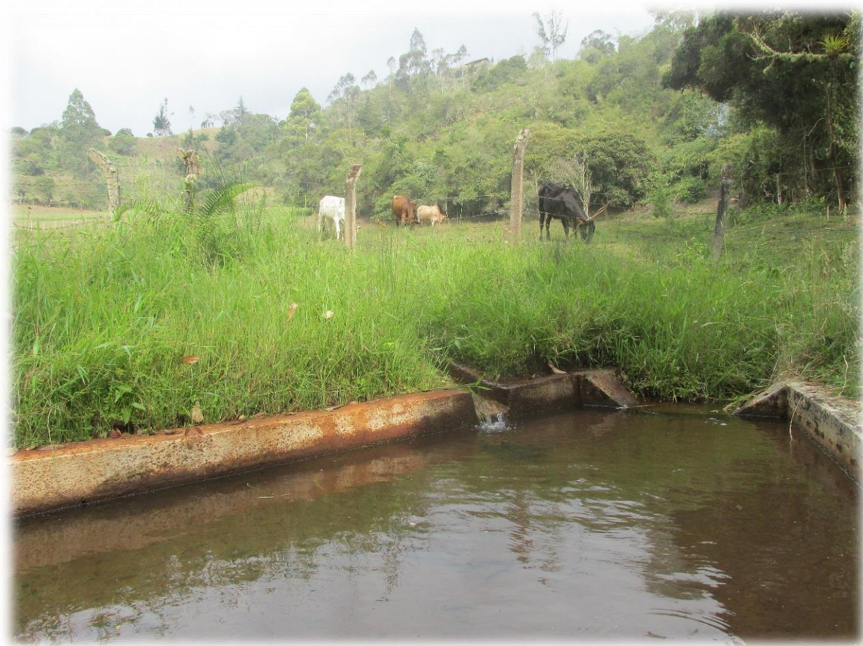
Fotografía 15 (Cantor, L 2016). Sistema de recolección de las aguas de un nacimiento cercano
