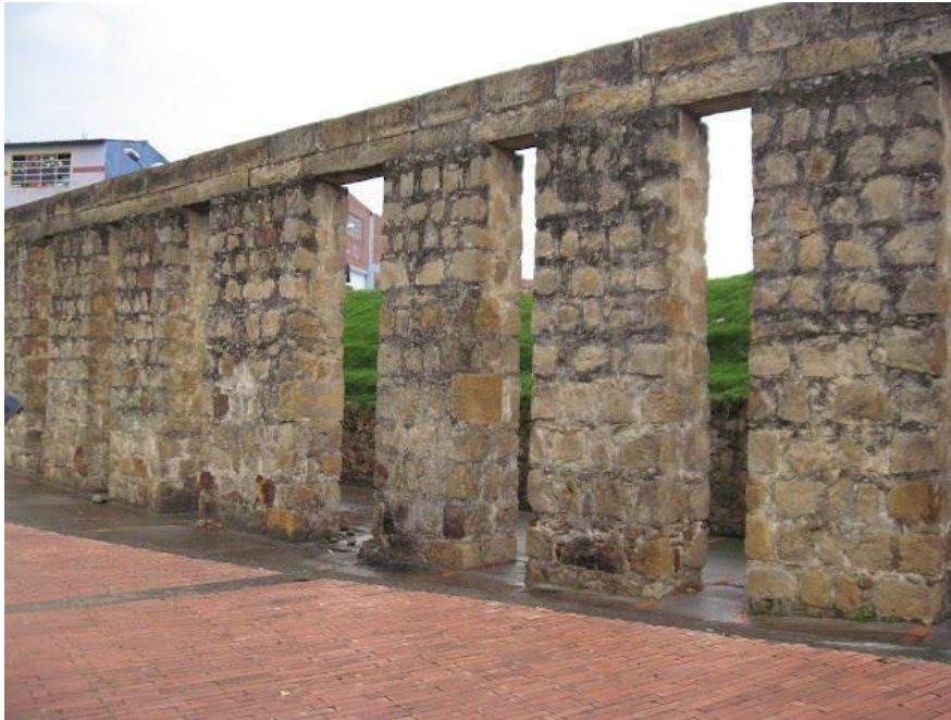
Fuente: Puente del Indio - Ciudad Bolívar, Arboleda Alta.
