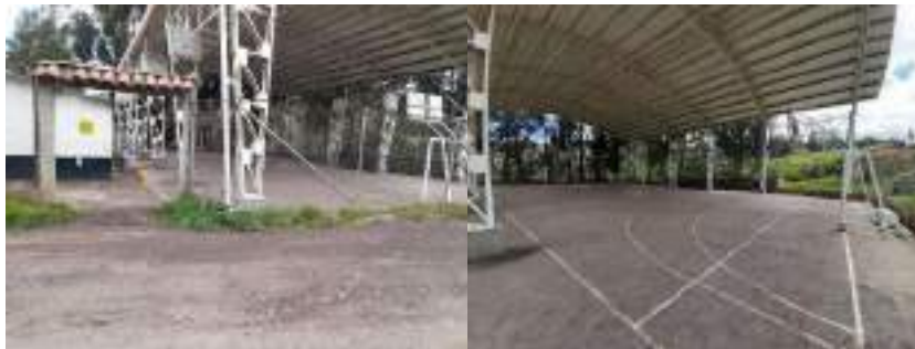
Figura 30 (Martínez H, 2021). Cancha de la escuela La Ramada.
