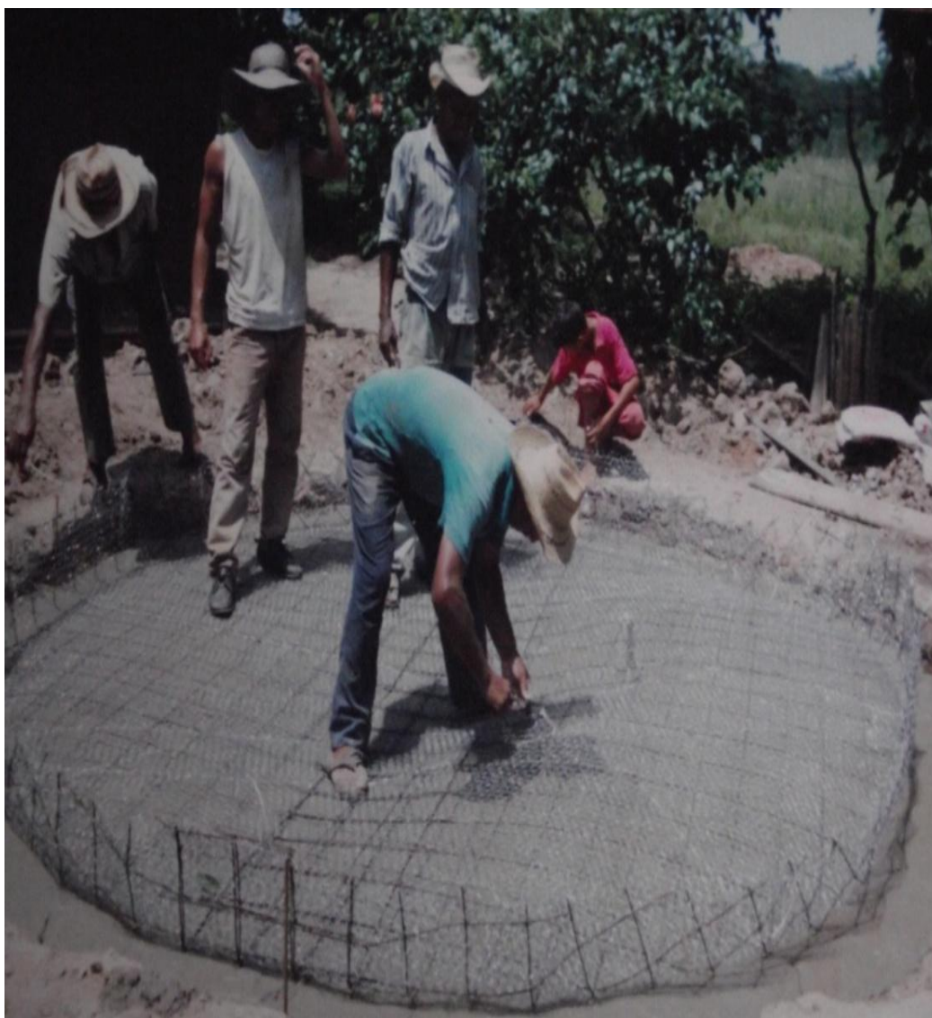
Figura 18. Construcción de los tanques de ferrocemento 1. Archivo institucional. Corporación Tiempos de Vida.
