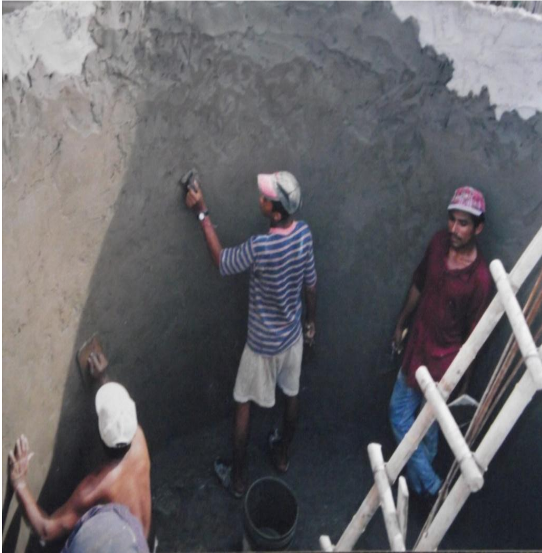
Figura 20. Construcción de los tanques de ferrocemento 2. Archivo institucional. Corporación Tiempos de Vida.
