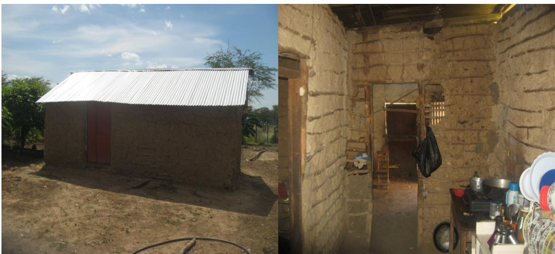
Así eran las viviendas que se construían en El Descanso (Archivo personal: diciembre de 2012) / Así luce por dentro una vivienda de barro (Archivo personal: enero de 2017).
